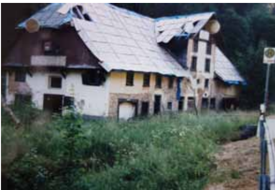
Wirtschaftsgebäude des ehemaligen Illmühle-Areal vor dem Abriß.
