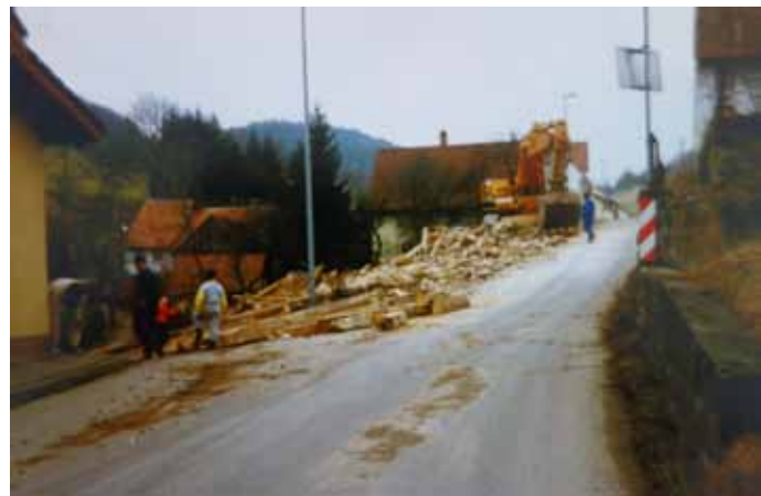
Haus Rebmann wird abgerissen für die schnellere Durchfahrt.
